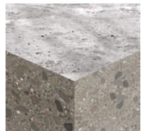
Hormigón no fisurado
