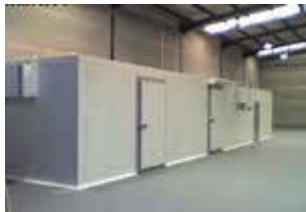
Uniones paneles sandwich en instalaciones frigoríficas
