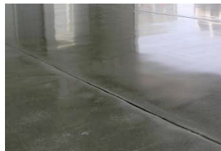
Juntas de pavimentos interiores transitables
